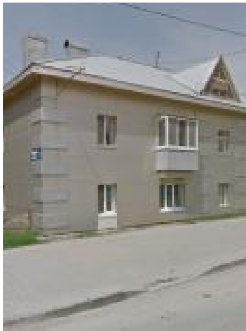
16. Жилой дом, ул. Курильская, 2
