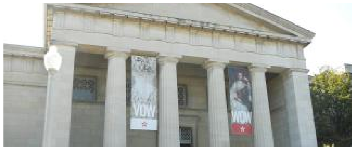
ХОРОШО. Временные баннеры не закрывают фасад, их размеры и расположение учитывают архитектуру портика
