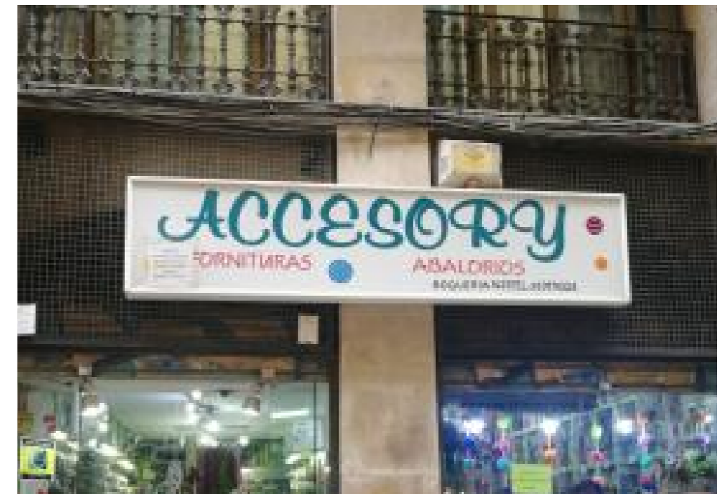
ПЛОХО. Вывеска на подложке не учитывает архитектуру фасада
