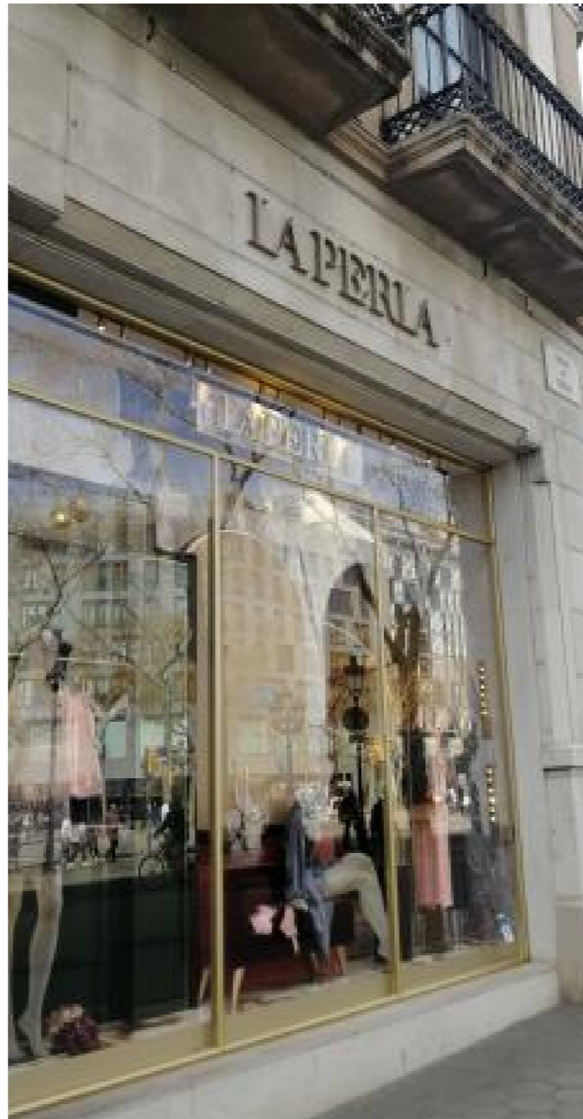
ХОРОШО. Вывеска без подложки сочетается по цвету с фасадом здания
